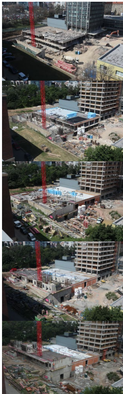
Výstavba depozitáře H1
